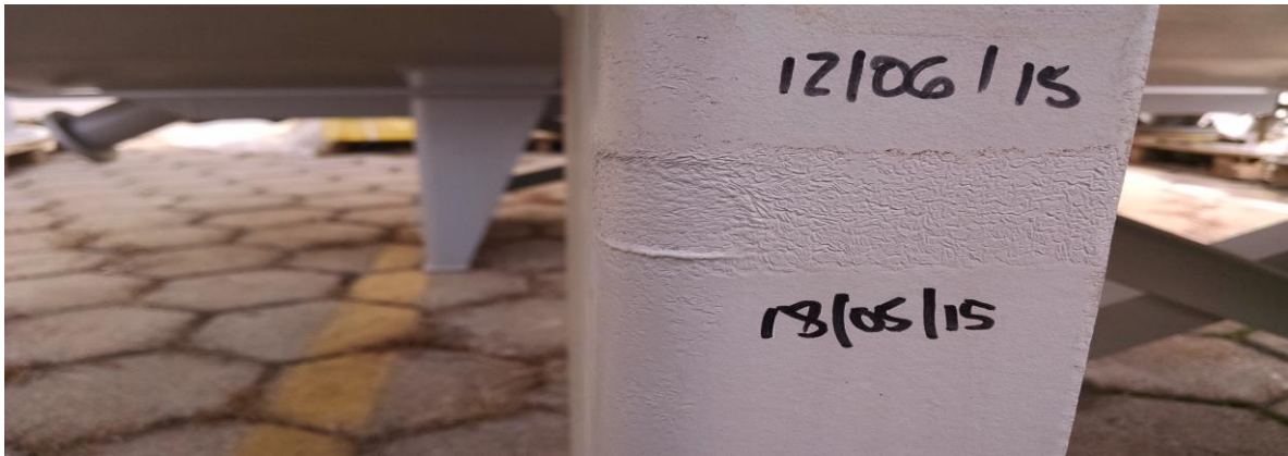
Figura 12 – Aspecto da Pintura DTM Acrílica após cintamento depois de 48h da aplicação e com 168h de cintamento.
