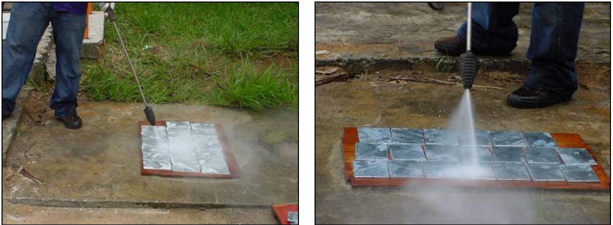
Figura 1 – Execução do pré-tratamento de lavagem com alta pressão – hidrojateamento.
